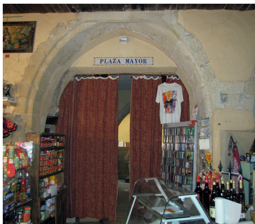
[617] Grand enfeu médiéval ménagé dans le mur ouest de la nef.
